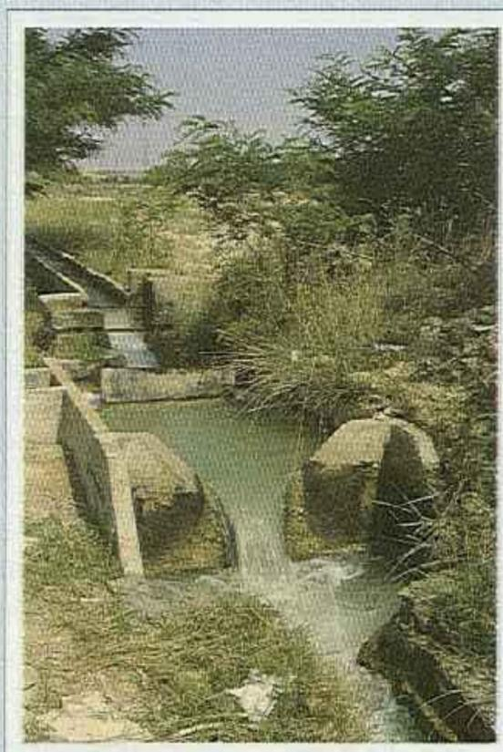
Vertedero triangular construido en hormigón.
