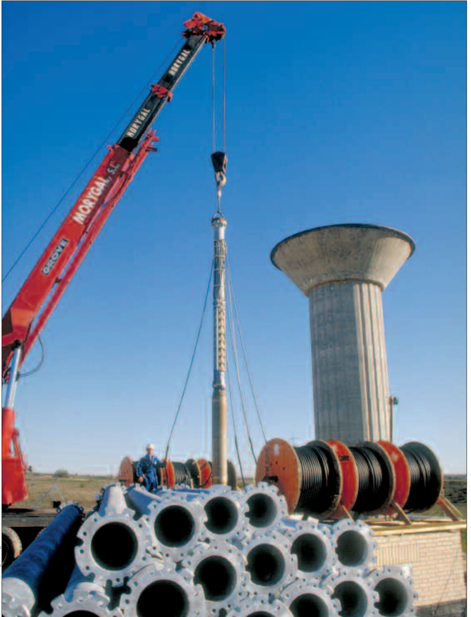
Perforación de un pozo en Fuencarral. Introducción de la bomba y motor de succión. Depósito, al fondo.
